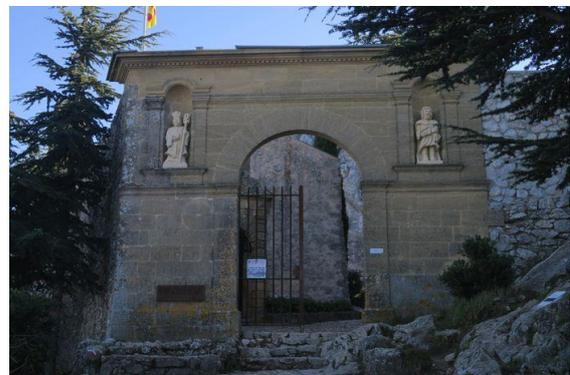
Tous ces travaux nécessitèrent une intendance inouïe pour transporter à dos de mulet les pierres de taille, la chaux, le sable, la charpente de bois et même l'eau, sans oublier bien sûr, le ravitaillement des ouvriers. Un chercheur a estimé à 215 tonnes la quantité de pierres de Bibémus utilisées dans la construction et à 358 tonnes le mortier nécessaire. Avec un chargement moyen de 80 kg d'un mulet, je vous laisse imaginer le nombre de voyages nécessaires.
